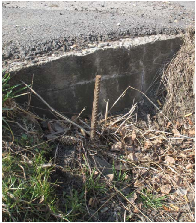
Obr. 4 a 5 – zanesené propustky podél ulice Hlavní
