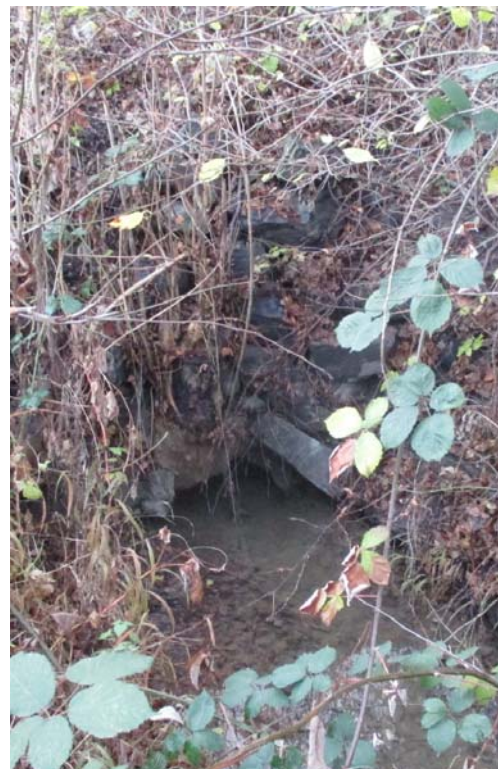
Obr. 3 – zanesené odtokové potrubí od požeráku – Horní rybník
