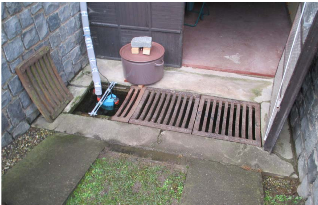
Obr. 8 – odčerpávání vody ze žlabu před suterénním prostorem domu č.p.157
