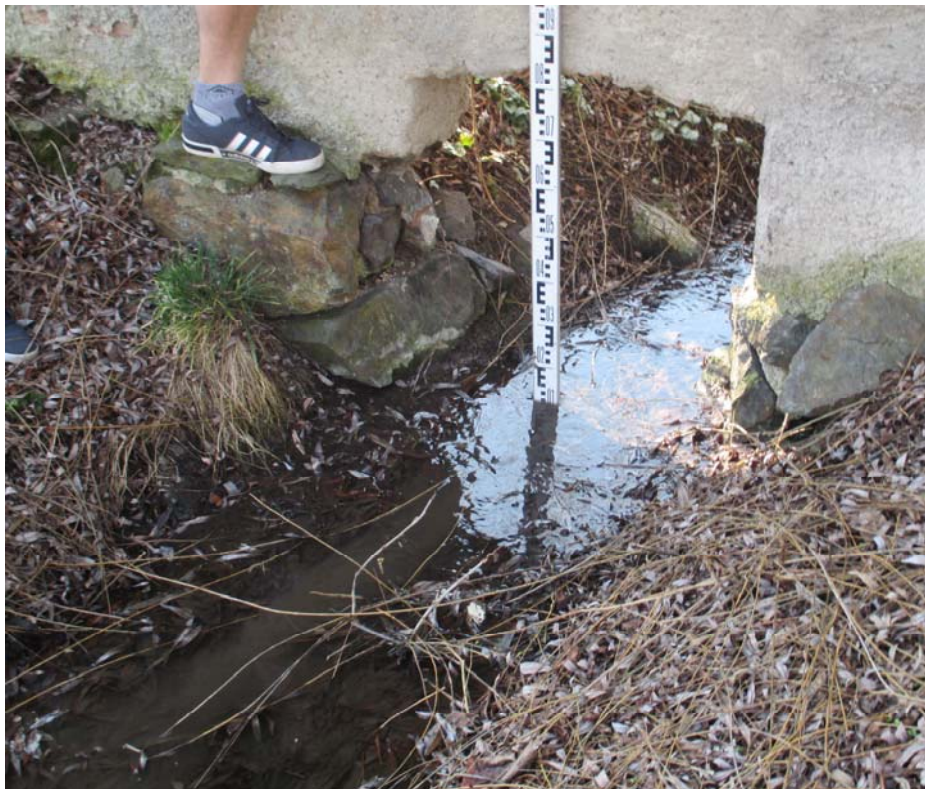
Obr. 6 – průchod toku Zlonínského potoka zděným plotem
