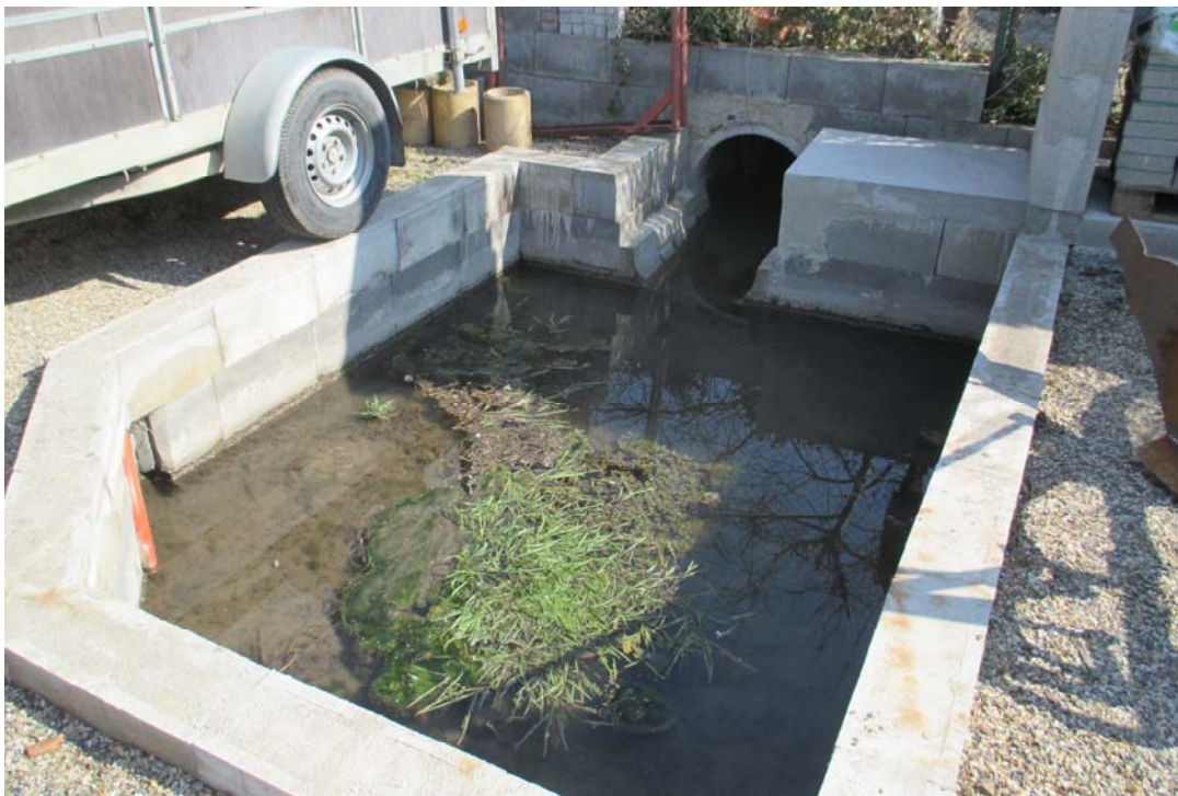
Obr. 10 – otevřený úsek zatrubněné části Zlonínského potoka v areálu zahradnictví
