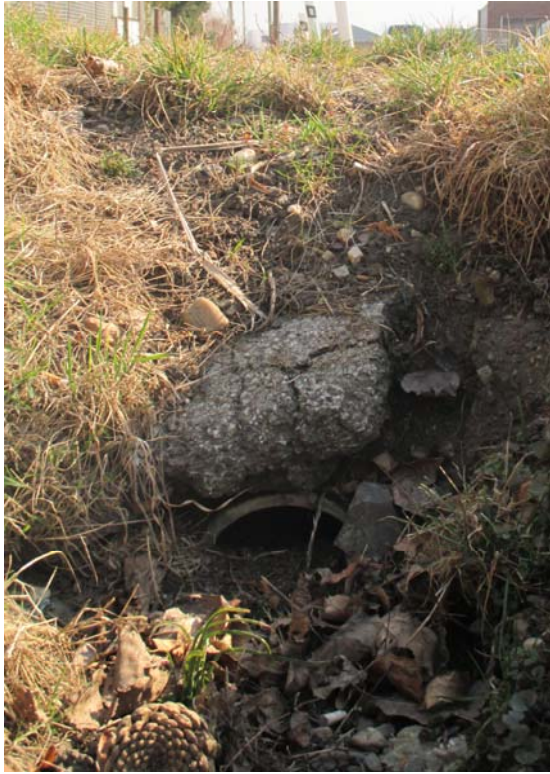
Obr. 4 a 5 – zanesené propustky podél ulice Hlavní
