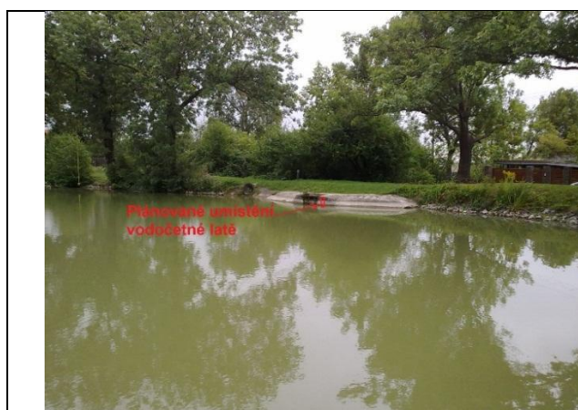
Foto G.2.1 Hráz s návrhem umístění vodočetné latě.
