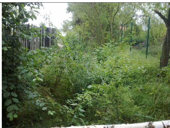
Foto G.2.10 Odpadní koryto od bezpečnostního přepadu, pohled od propustky po proudu.
