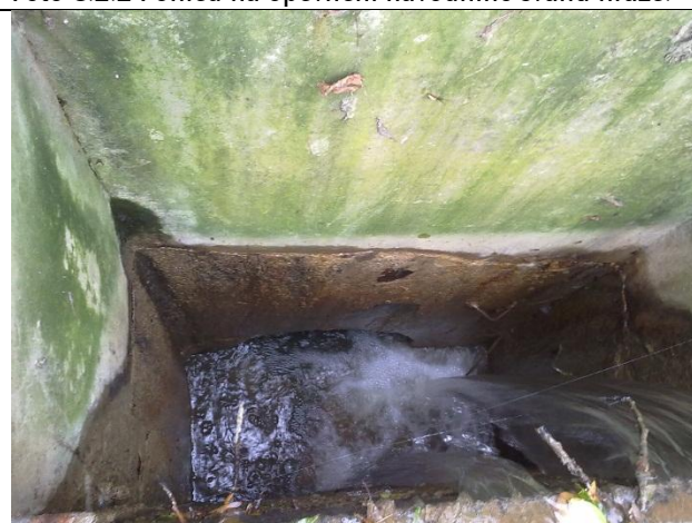
Foto G.2.4 Požerák, spádiště, odtok.
