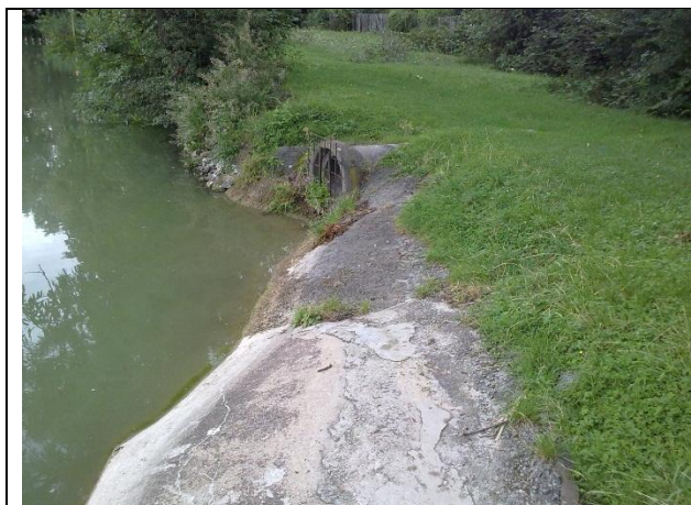
Foto G.2.5 Pohled na korunu hráze a vtok do bezpečnostního přelivu.
