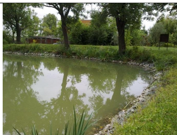
Foto G.2.2 Pohled na opevnění návodního svahu hráze.
