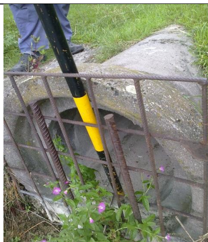
Foto G.2.6 Detailní pohled na vtok do bezpečnostního přelivu.
