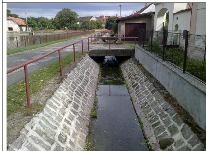
Foto G.2.9 Jižní hráz, vzdušná strana. Opevněné koryto Zlonického potoka.
