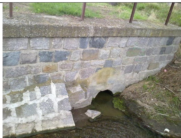
Foto G.2.8 Výtokové čelo od požerákové výpusti
