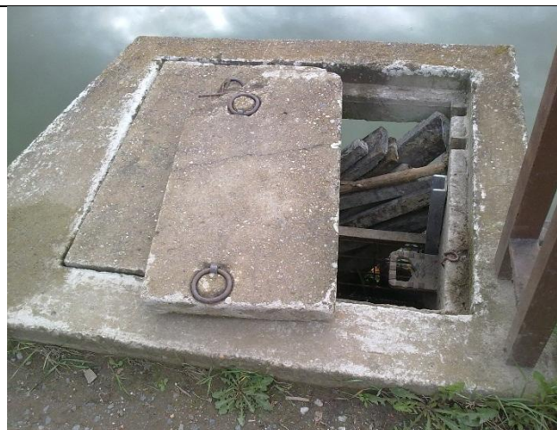
Foto G.2.6 Pohled na poklop požeráku
