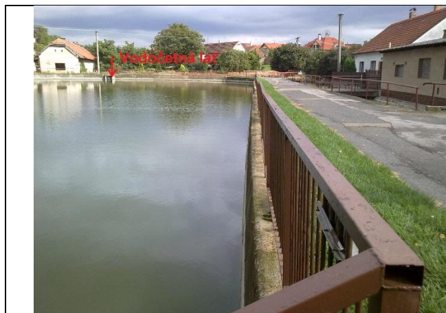
Foto G.2.1 Pohled na jižní hráz, červenou šipkou vyznačené místo pro instalaci vodočetné latě
