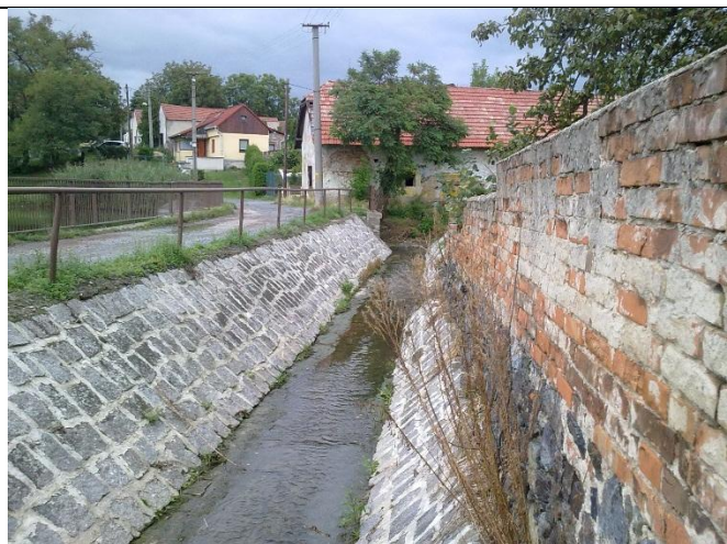
Foto G.2.5 Východní hráz, vzdušní strana. Opevněné koryto Zlonického potoka.
