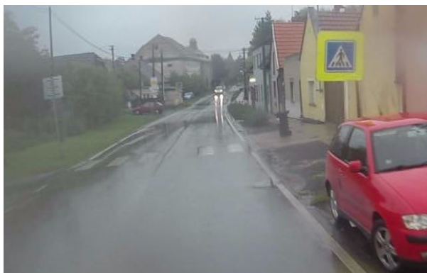
Obrázek 8 – Přechod pro chodce nevhodně napojen na pěší infrastrukturu
