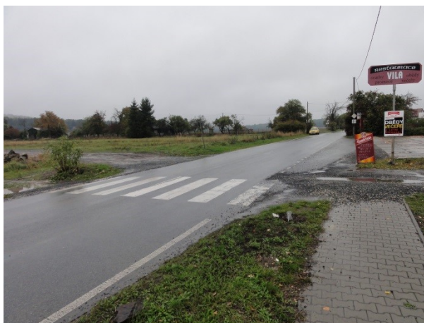
Obrázek 6 – Přechod pro chodce nevhodně napojen na chodníky
