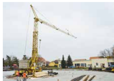
Stavba nového pavilonu Základní školy Foto: Martin Kupka
