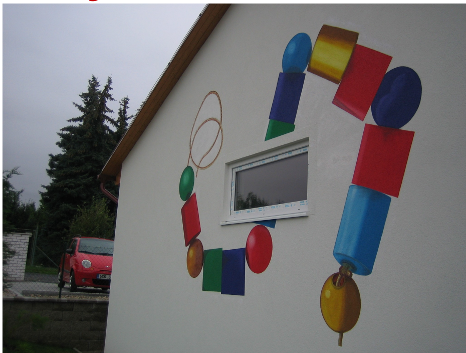
Dokončená fasáda nové budovy MŠ
